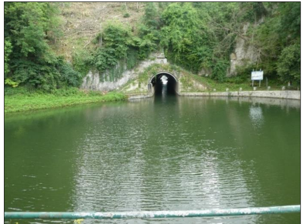
Schiffstunnel Thoraise, Wendebecken vor der Einfahrt
