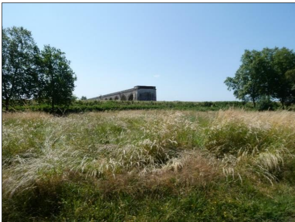
Viaduc des Noëls, Bestandteil der Bahnstrecke von Romorantin nach Blois war bis 1944 in Betrieb
